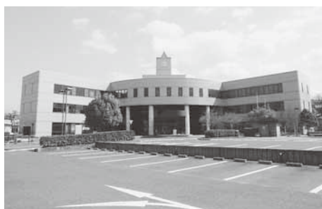
土岐市総合福祉センター・ウエルフェア土岐
