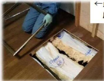
←点検口を作成して床下の確認と乾燥
