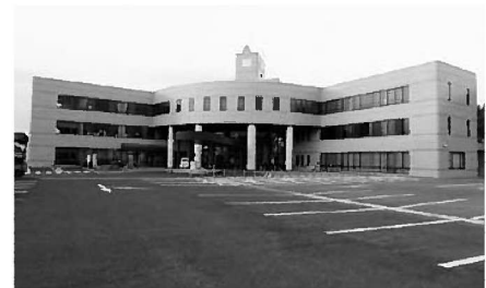
土岐市総合福祉センター・ウエルフェア土岐
